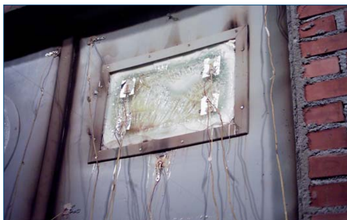
Prova al fuoco. Fire test.
